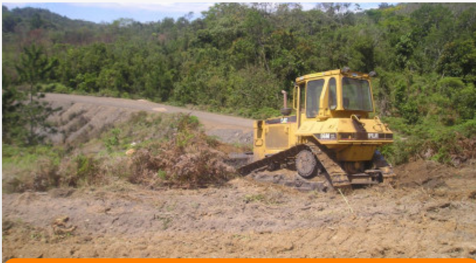
O trabalho de fechamento das bocas de minas começou em outubro
