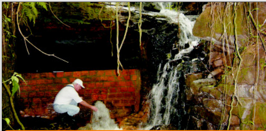
A entrada e a saída de água também foram identificadas pelos técnicos no trabalho realizado em Criciúma
