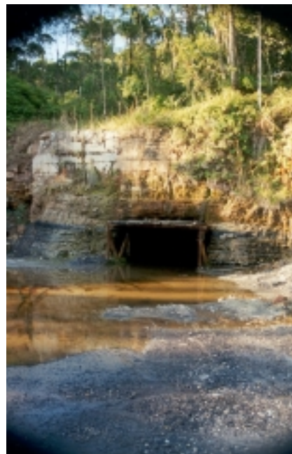
Foto 2 – Drenagem ácida oriunda de uma boca de mina abandonada na região carbonífera de Santa Catarina.
